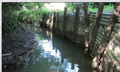
Protection de berge en tôle
