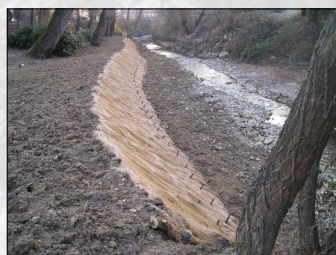
Géotextile et boutures
