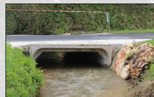
Dalot en béton
