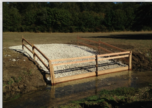
Descente aménagée avec traverses en bois
